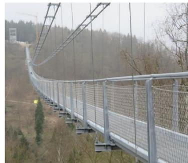
Vier Haupttragseile mit einem Durchmesser von 65 mm bilden das Rückgrat des Bauwerks. Zusätzlich wird die Brücke mit 2 Stabilisierungsseilen mit einem Durchmesser von 36 mm in Form und bei höheren Windgeschwindigkeiten in Position gehalten. Bei Windstärken größer 6 Beaufortskala (Bft) muss die Brücke auf Grund von zu großen Schwankungen geschlossen werden.
